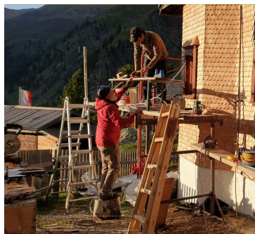
Arbeiten an der Fassade
